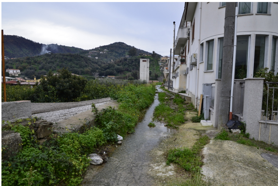
foto 7 - Canale torrente Bruca poco a monte della Via C. Antica
