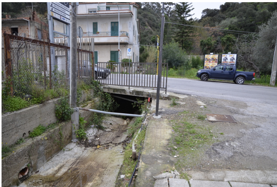
foto 5 - torrente Salico - tombino sotto la via Consolare Antica
