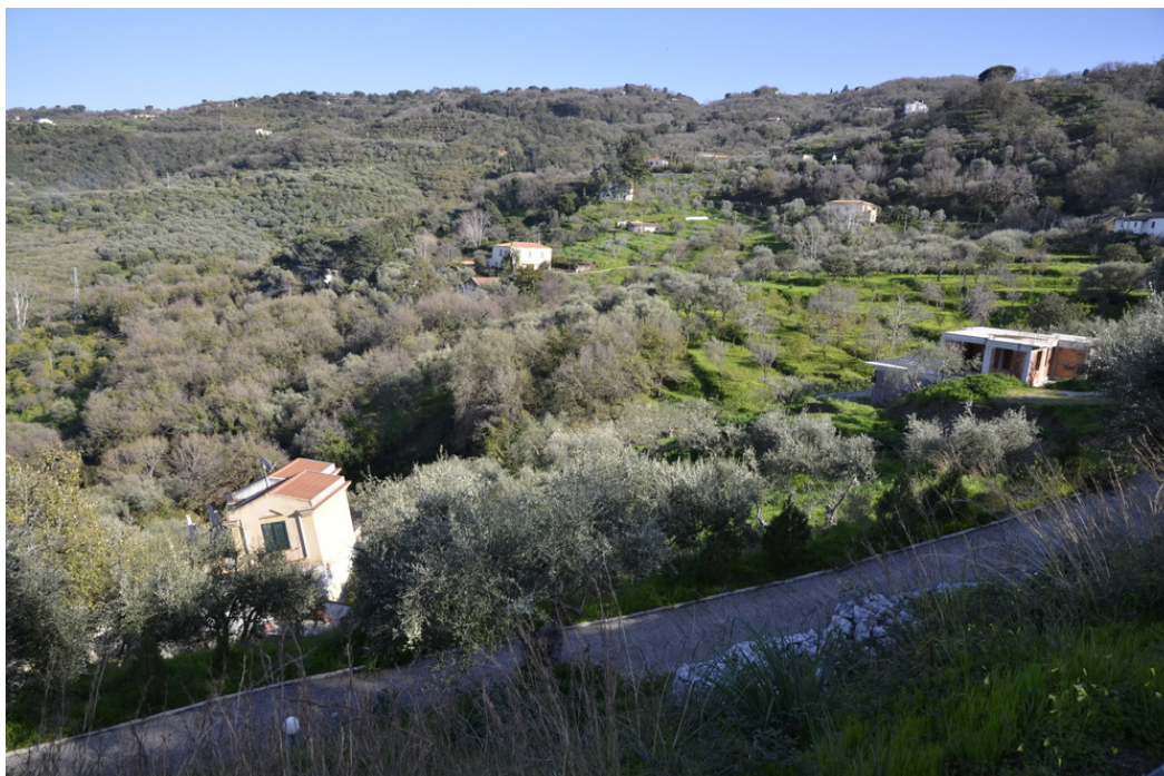
foto 1- riattivazione frana di Marmoro
