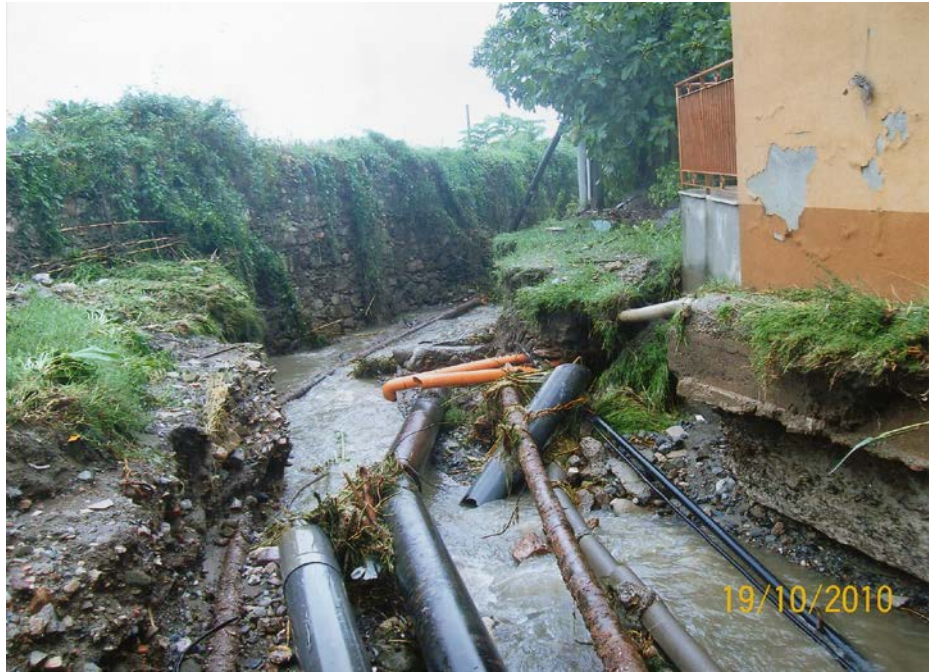
foto 13 - Torrente Piscittina dopo l'intersezione con la SS 113
