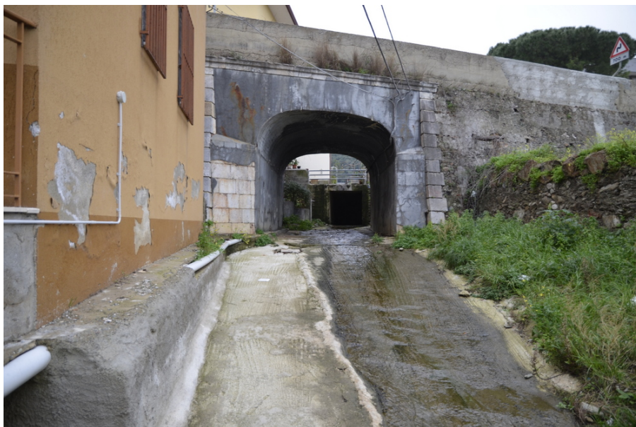
foto 3 - Vallone Piscittina, sbocco canale tombinato e attraversamento SS 113
