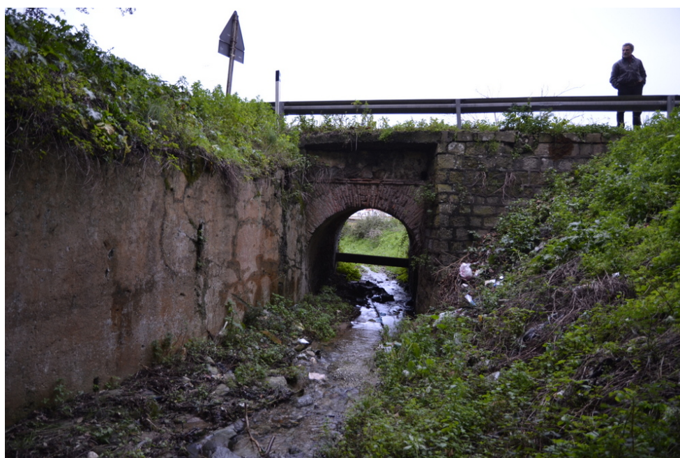
foto 8 - Attraversamento Torrente Bruca-Pietralonga alla SS 113
