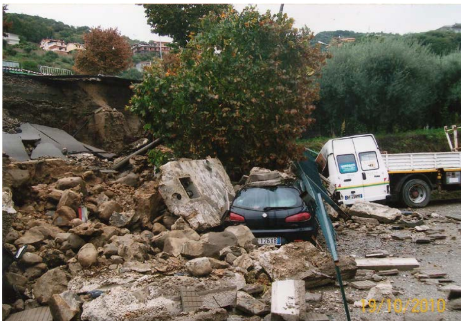
foto 11 - Cedimento del canale tombinato e del vecchio argine del Torrente Forno
